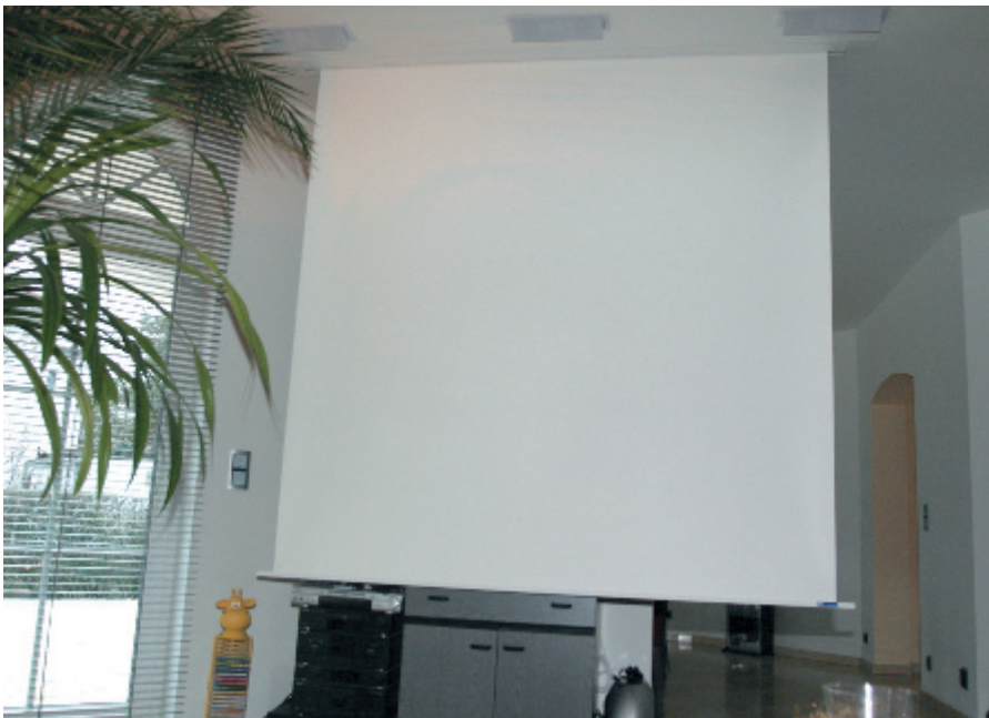
Inceiling-Leinwand von Cinescreen und Inceiling-Lautsprecher von KEF
