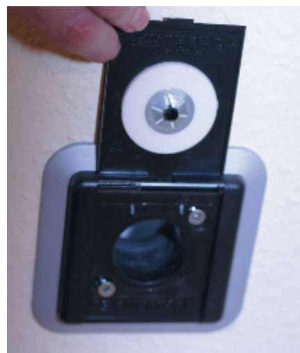
Wanddose für den Saugschlauch
